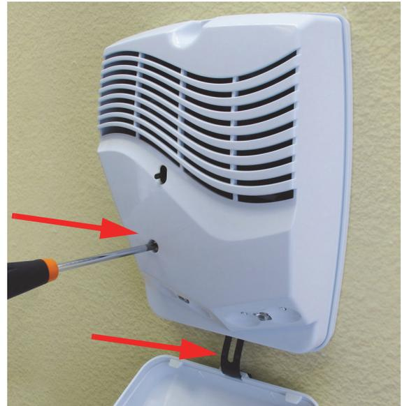
Aprire il coperchio interno rimuovendo la vite posta sopra la barra dei LED. Sfilare il coperchio interno, spostandolo leggermente verso destra e posizionarlo sul coperchio esterno che, con la sua conformazione, lo potrà sorreggere durante le fasi di installazione.
